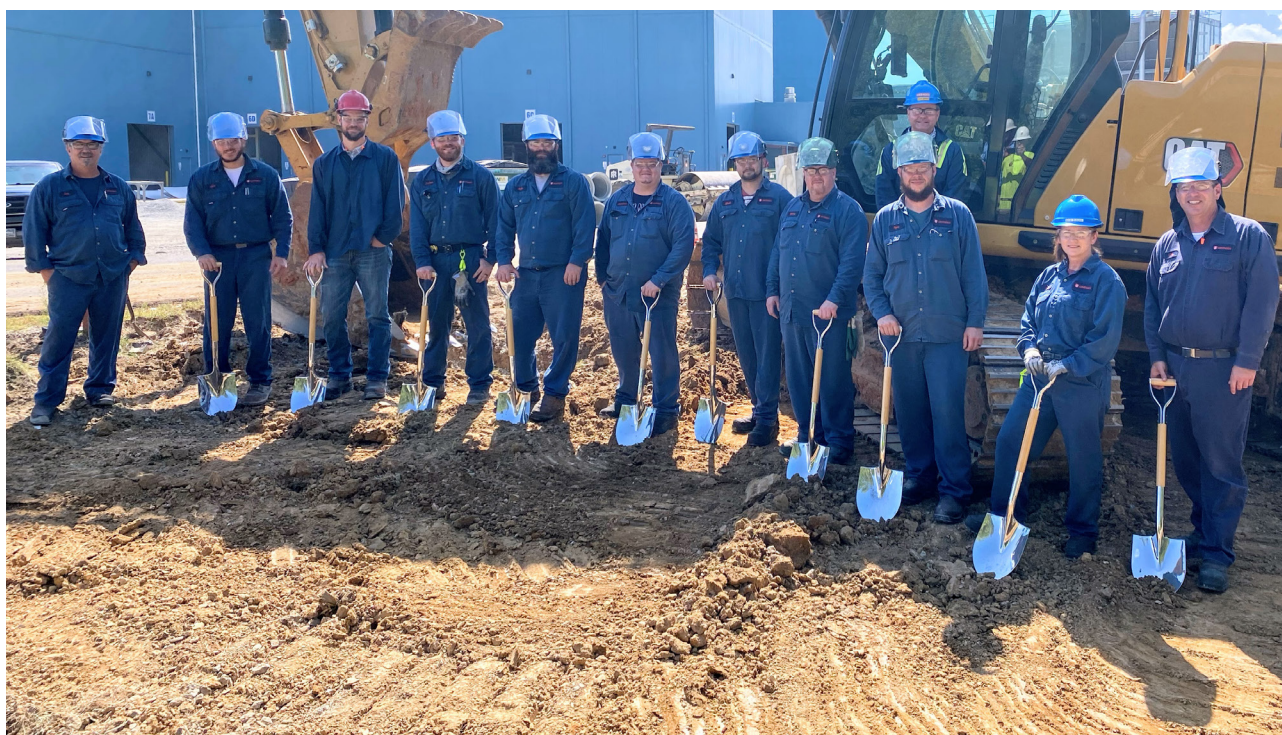
Första spadtaget inför installationen av en ny gjutugn i anläggningen i Huntingdon, Gränges Americas.
